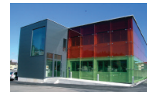
Die neue Verkehrsmanagementzentrale VMZ-CH in Emmen/LU.
